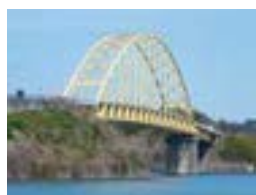
2号橋(大矢野橋)
